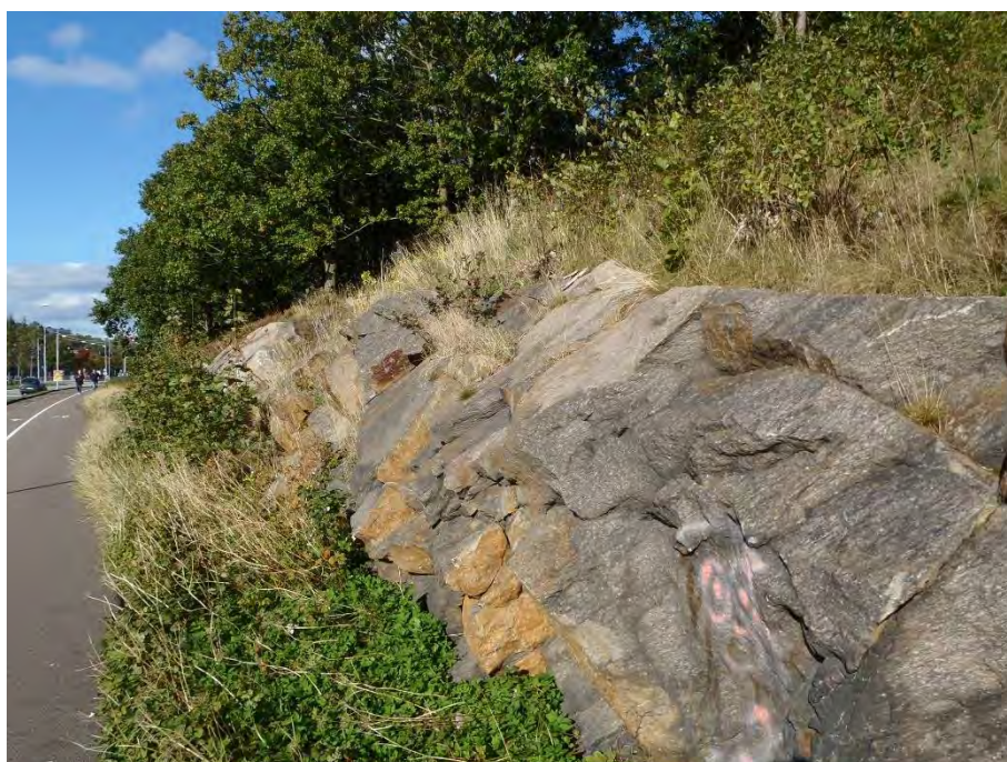
Figur 4.5. Åtgärd nr 3 i framsprängd bergskärning med överhäng.
