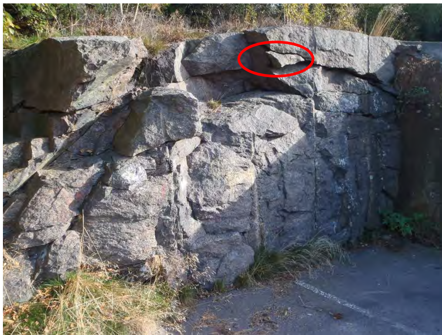
Figur 4.6. Åtgärd nr 4 i framsprängd skärning med instabilt block markerat.
